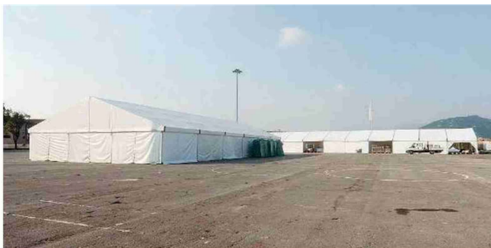
Due maxi tendoni. Le due aree destinate ad accogliere parte della nuova struttura sanitaria// FOTOSERVIZIO NEG
