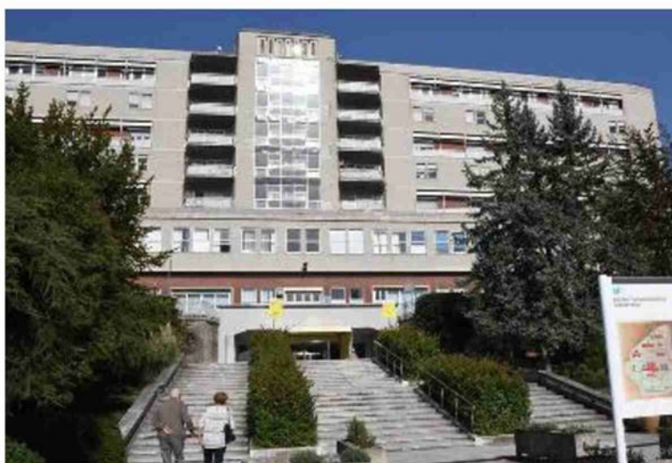
Il monoblocco, dopo le prescrizioni dei vigili del fuoco, dovrà essere chiuso per una radicale opera di messa in sicurezza. Saranno spostati i servizi
