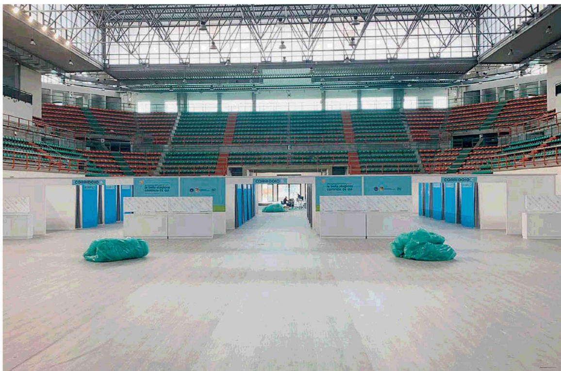
Palazzetto di San Filippo La Protezione Civile regionale ha concluso i lavori di costruzione dell'hub
